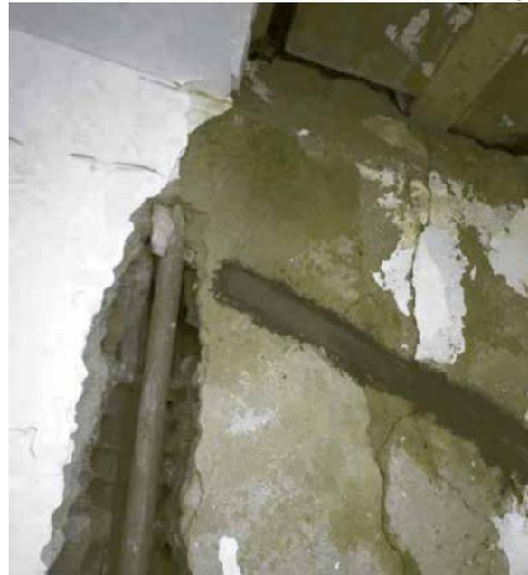
Prédio apresenta, segundo a fiscalização da PMJP, problemas graves, a exemplo de fissuras de um lado a outro da viga e deformação da laje, que são fundamentais para a segurança da estrutura
